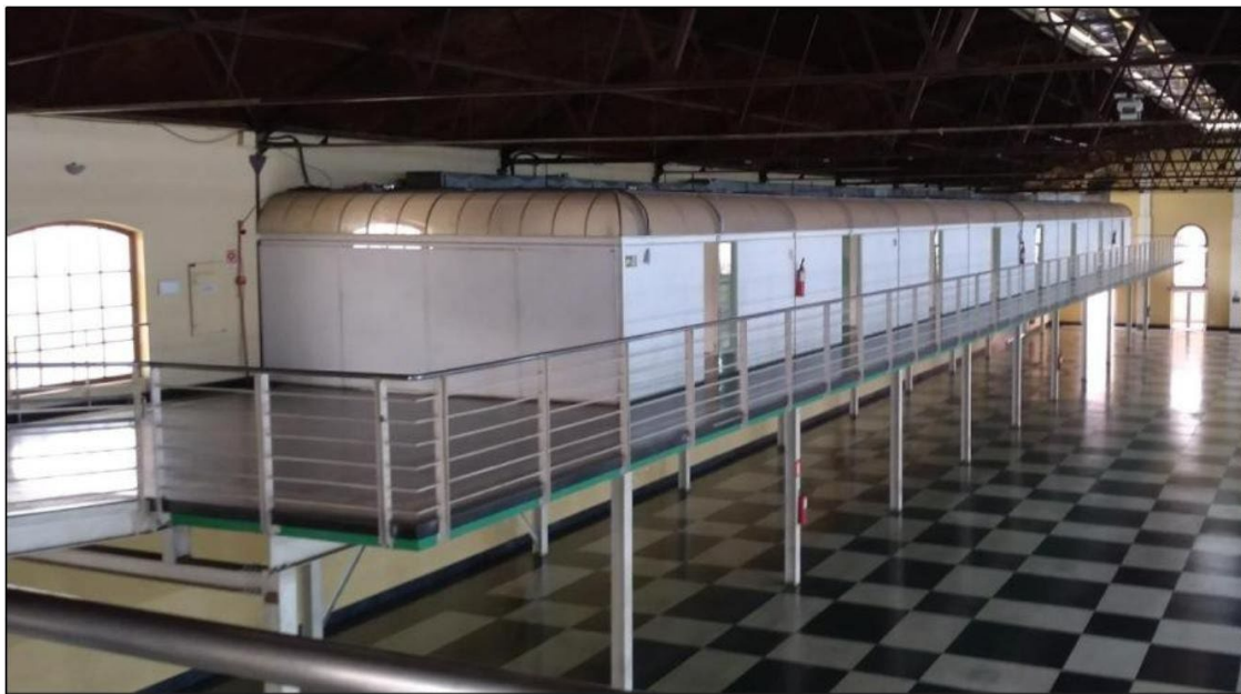
Figura 9 – Mezanino Pavilhão Principal
