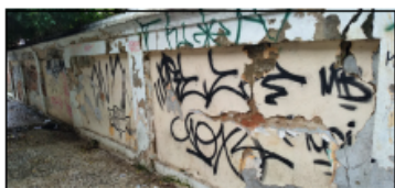
TRATAMENTO DOS REVESTIMENTOS/ PINTURAS DOS MUROS
