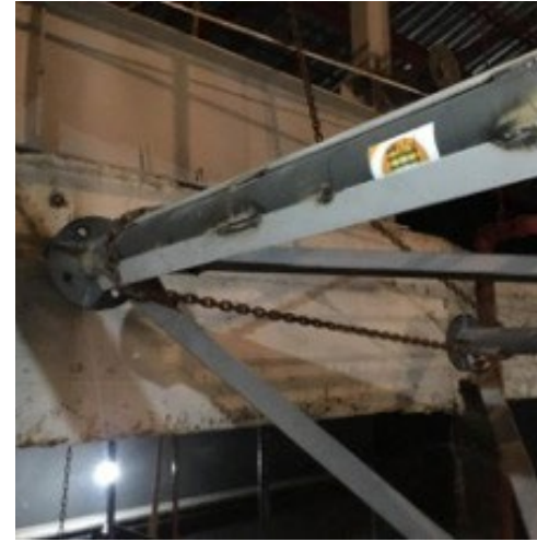
Ampliação do reforço metálico da estrutura do palco do Grande Teatro.
